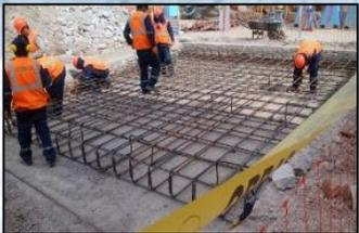
**OBRA:** "REPARACIÓN DE LOSA DE CONCRETO ARMADO DE 4.5M X 13M Y REUBICACIÓN DE COMPRESOR EN TALLER"
