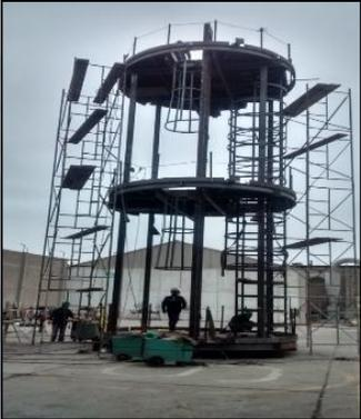
**OBRA: "SUMINISTRO Y FABRICACION DE ESTRUCTURAS METALICAS PARA GALLOWAY TILEY (CONSTRUCCION DE TUNEL VERTICAL)"**
